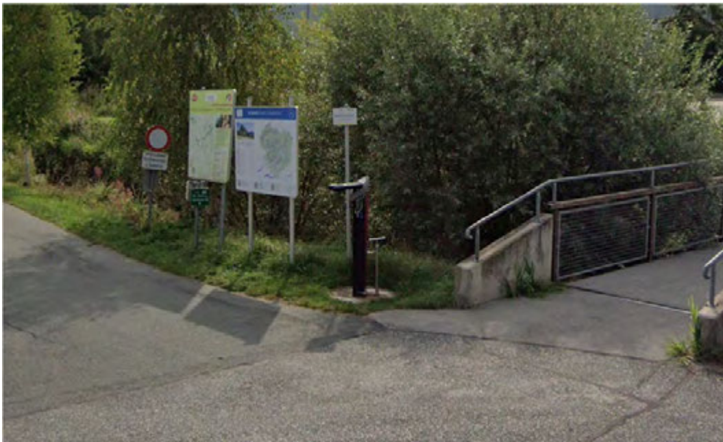
Abbildung 48: Servicestation R5 – Pumpstation Hörzendorf (Quelle: google streetview)
