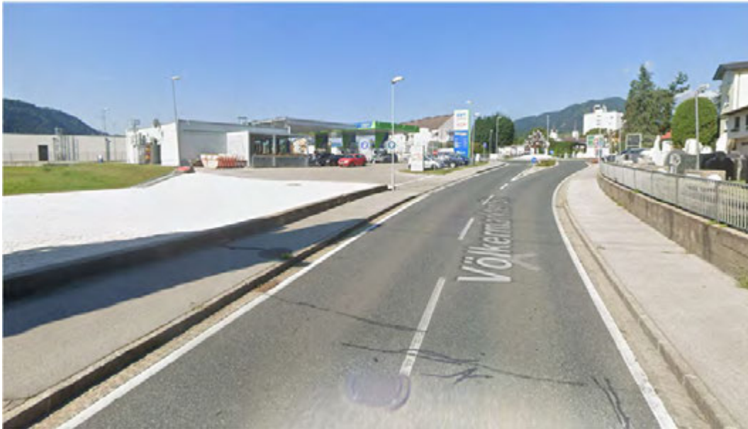
Abbildung 27: Bereich Anschlussstelle S7 bis Unterführung ÖBB (Quelle: google maps)
