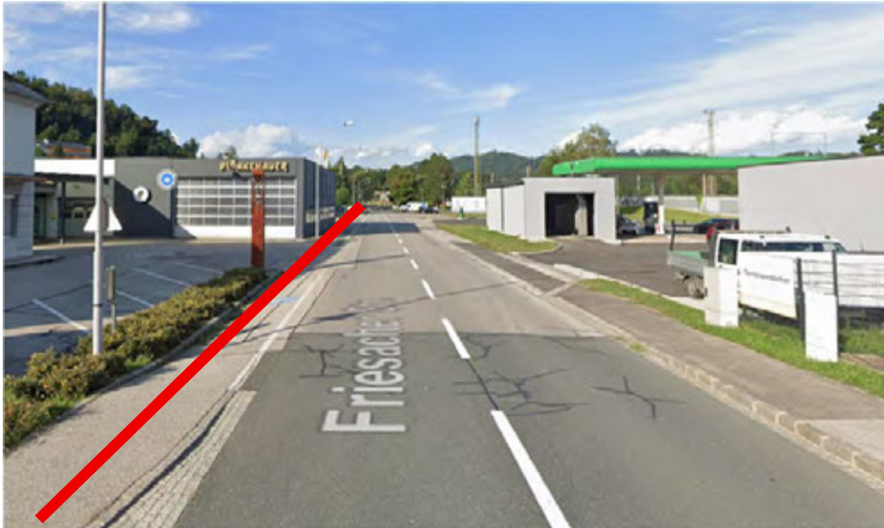
Abbildung 18: Bereich Friesacher Straße – Höhe Tankstelle (Quelle: google maps)
