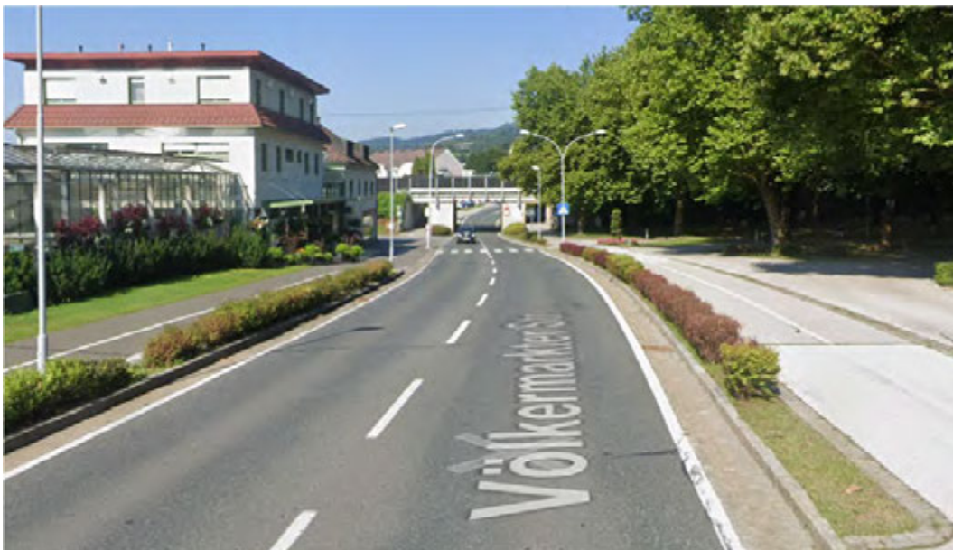
Abbildung 26: Bereich Anschlussstelle S7 bis Unterführung ÖBB (Quelle: google maps)
