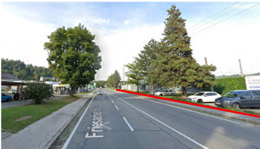
Abbildung 12: Bereich B94 Ossiacher Straße (Villacher Straße) nach Bahnhof – Verbreiterung Gehsteig (Quelle: google maps)
